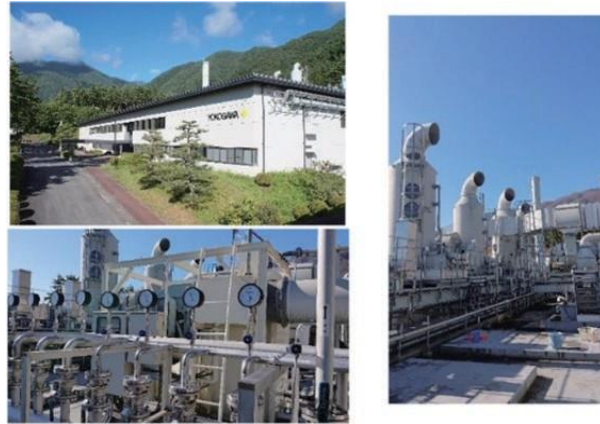
그림 4 Yokogawa 코마가네 제조 공장의 건물 외관 및 옥상 검사 구역
